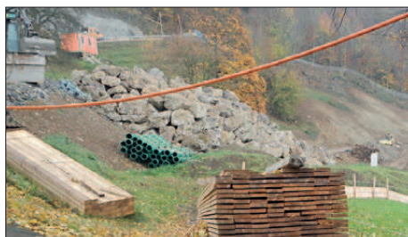
Unterer Schutzdamm der Massnahmen Linden, der sich noch im Bau befindet. Foto: zvg
